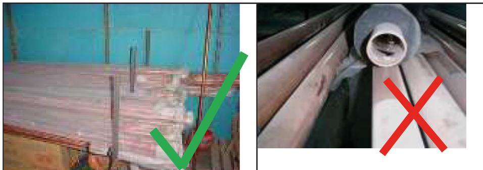
Не устанавливайте трубу во время дождя, чтобы предотвратить попадание воды; блокирование капилляра или расширительного клапана, образование кислотной эрозии железа / меди из-за гидролиза хладагента, образование кристаллов посторонних веществ (соединений каркаса) из-за реакции холодильного масла.
