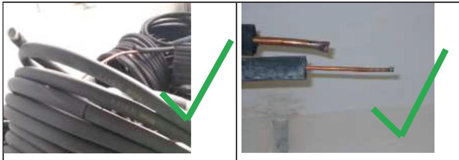
Не допускайте попадания в систему пыли, такте как осколки бетона, песок и медный шлак.
