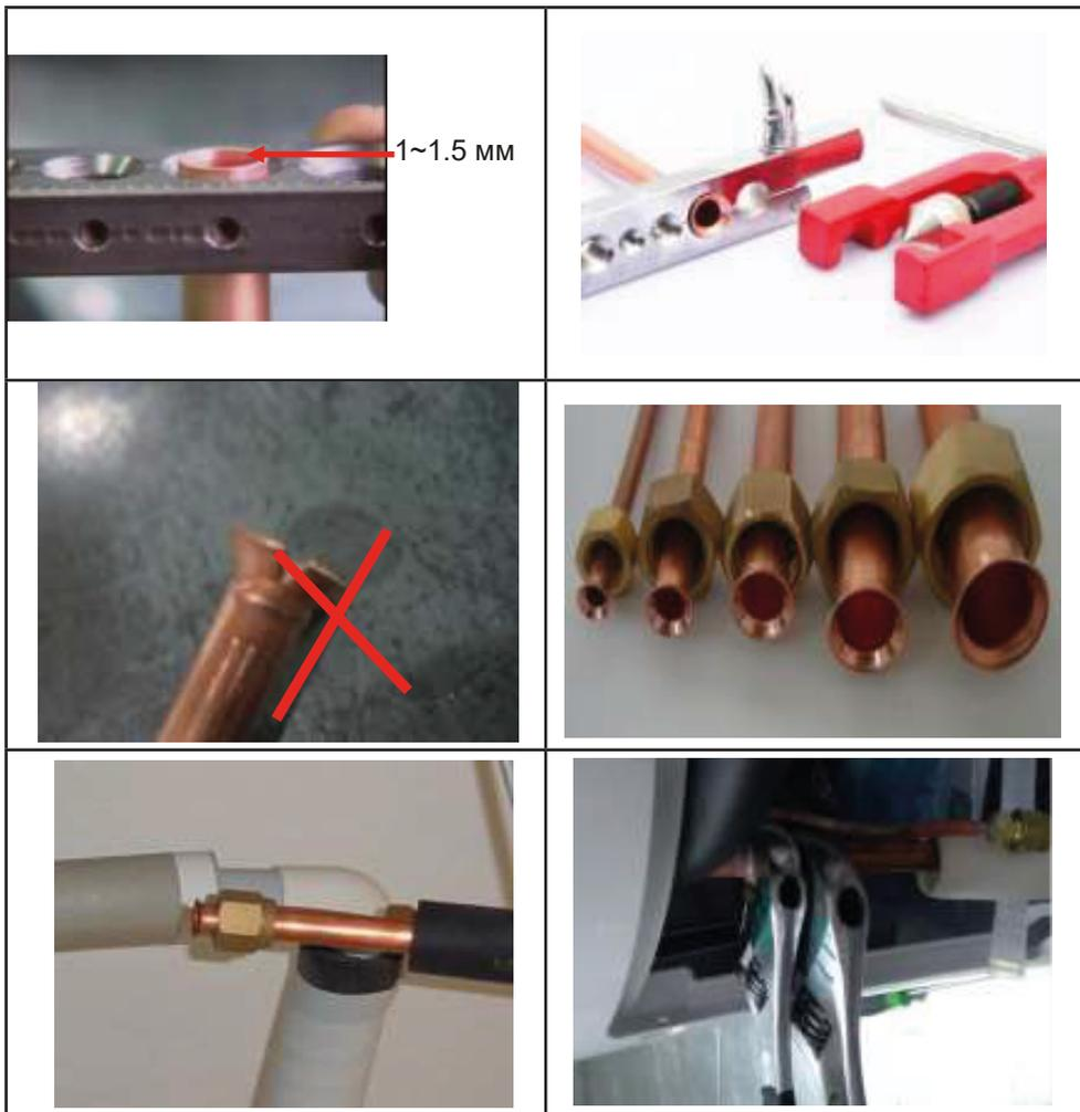
Развальцовочная труба с расширителем в соответствии с размерами развальцовочного отверстия в следующей таблице.
